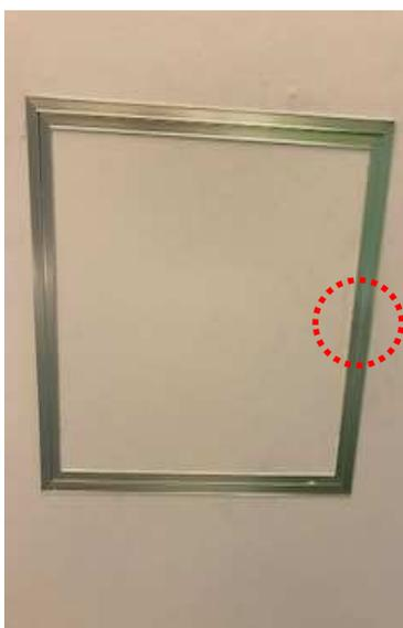
マイナスドライバーを使ってロックを外します。※ロックを外したことにより点検口が勢い良く落下する可能性がある為、手で抑えながら開けましょう。
